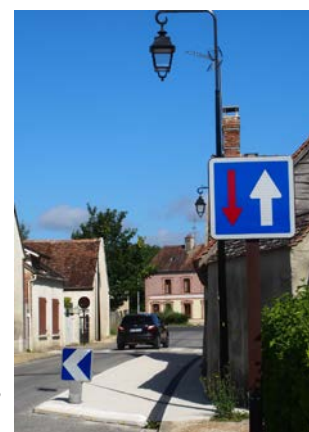
Ecluse-trottoir rue Grande
